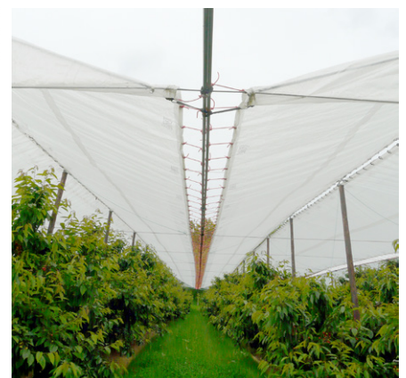
Overkappingen met oprolsysteem.
